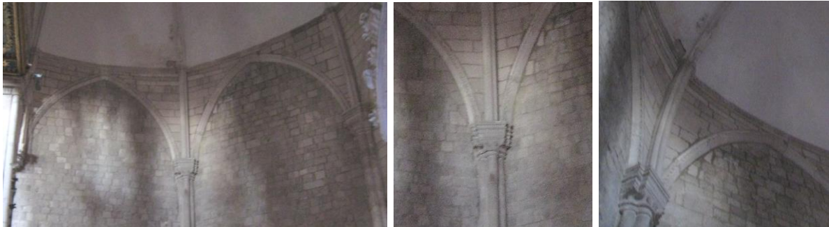
Dubrovnik, crkva sv. Dominika, svod apside – detalji: službe, baze, kapiteli, rebra
