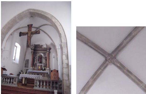
Zadar, crkva Sv. Mihovila, svod u apsidi; križanje rebara
