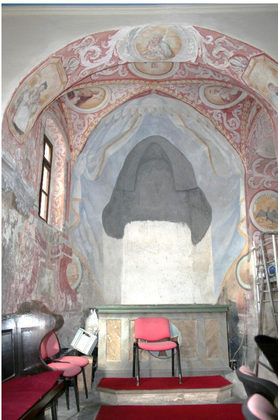
Sl. 110. Slavetić, župna crkva, bočna kapela sv. Barbare, tijekom restauratorskih zahvata 2018. (foto: PBM)
