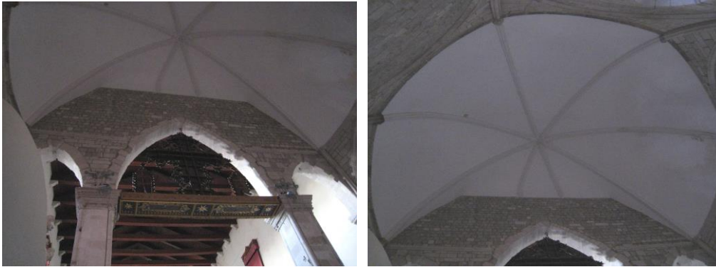
Dubrovnik, crkva sv. Dominika, svod apside
