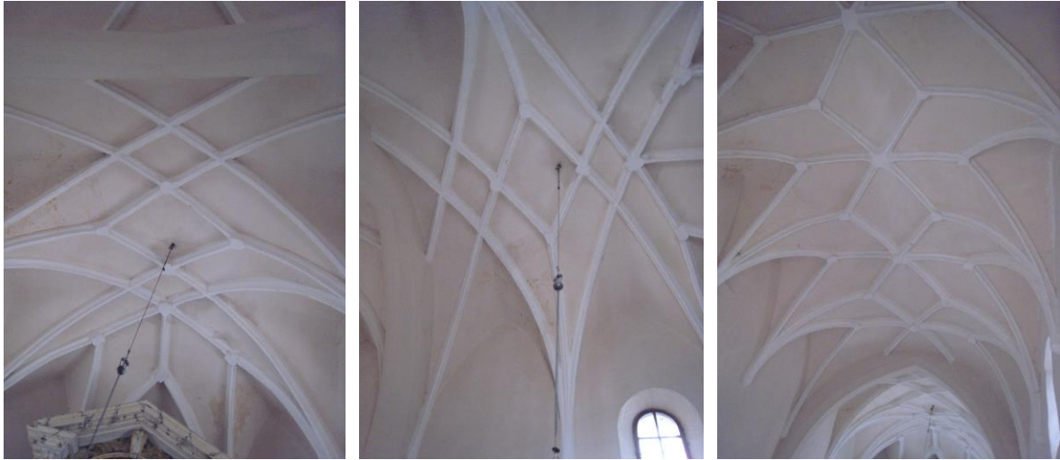
crkva sv. Antuna opata u Roču – svod svetišta i svod broda
