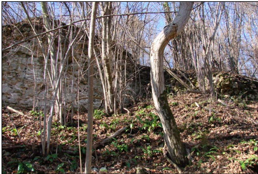
prilog 57 - istočni zid grada Stjeničnjaka (stanje svibanj 2010., foto: Milan Kruhek)
