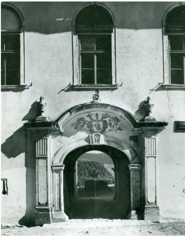
Sl. 40. Glavno pročelje dvorca Oršić u Gornjoj Stubici, 1940. god. (foto: Fotoarhiv JAZU, MK-UZKB/SA, inv. br. 17051; neg.)
