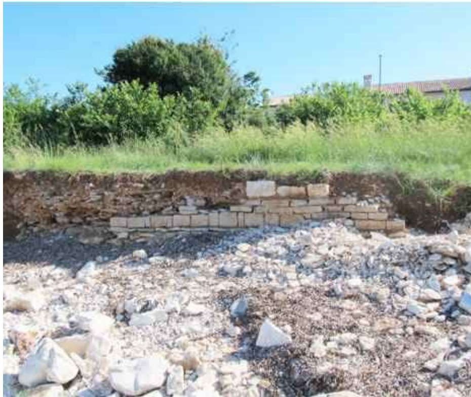
Slika 35. Pošesi, rimski zid (foto: D. Bulić)
