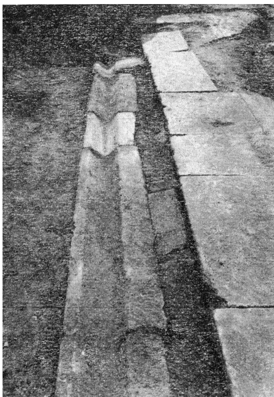
Slika 61. Kameni rubnjak i žlijeb peristila (B. ILAKOVAC, 1958, 48).
