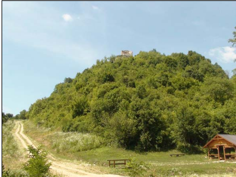
prilog 39 - pogled sa juga na utvrdu Zrin (stanje: travanj 2009.)
