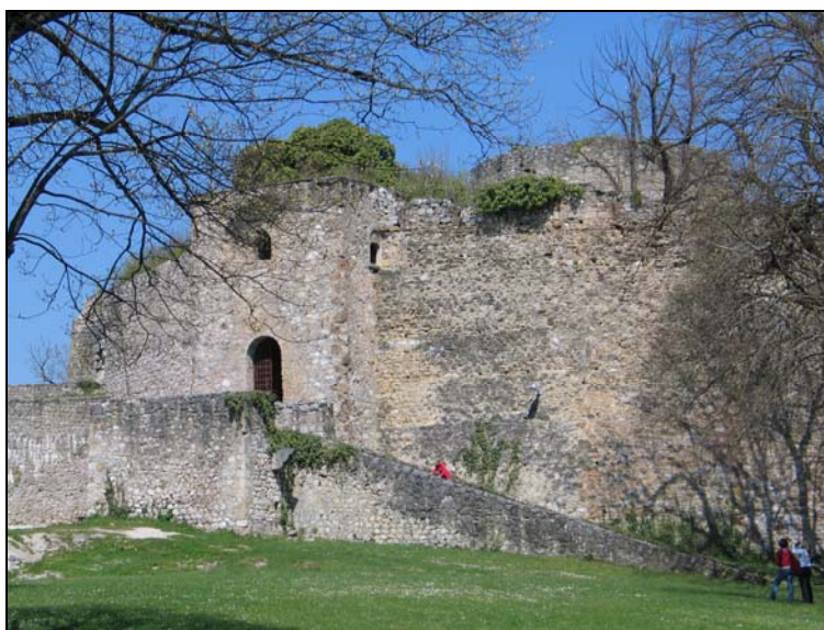
prilog 48 - sjeverna kula grada Ostrošca (stanje: svibanj 2010.)
