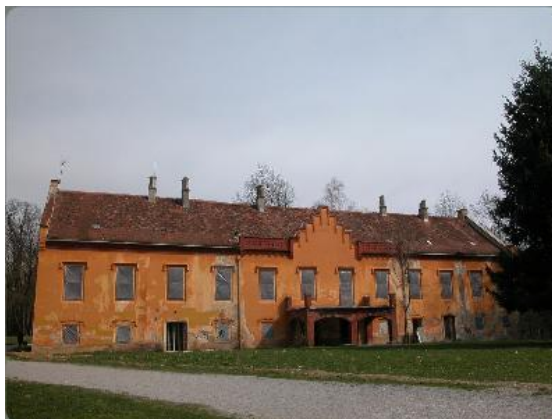
Novi dvori (kompletna obnova u tijeku)
