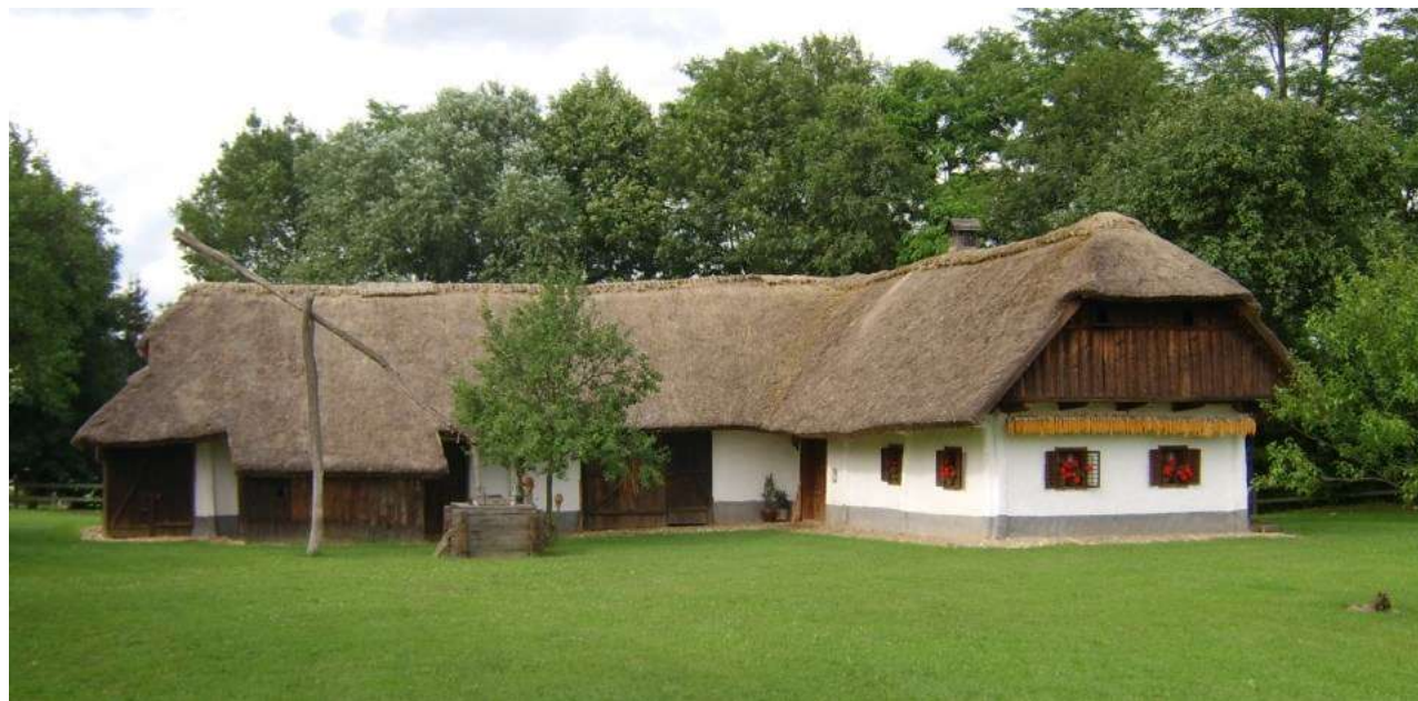
Slika 1: Obnovljena Dominkova domačija v Gorišnici (foto: arhiv avtorice).
