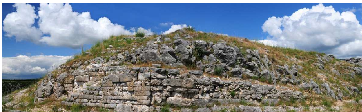
4. Potporni zid velike gomile
