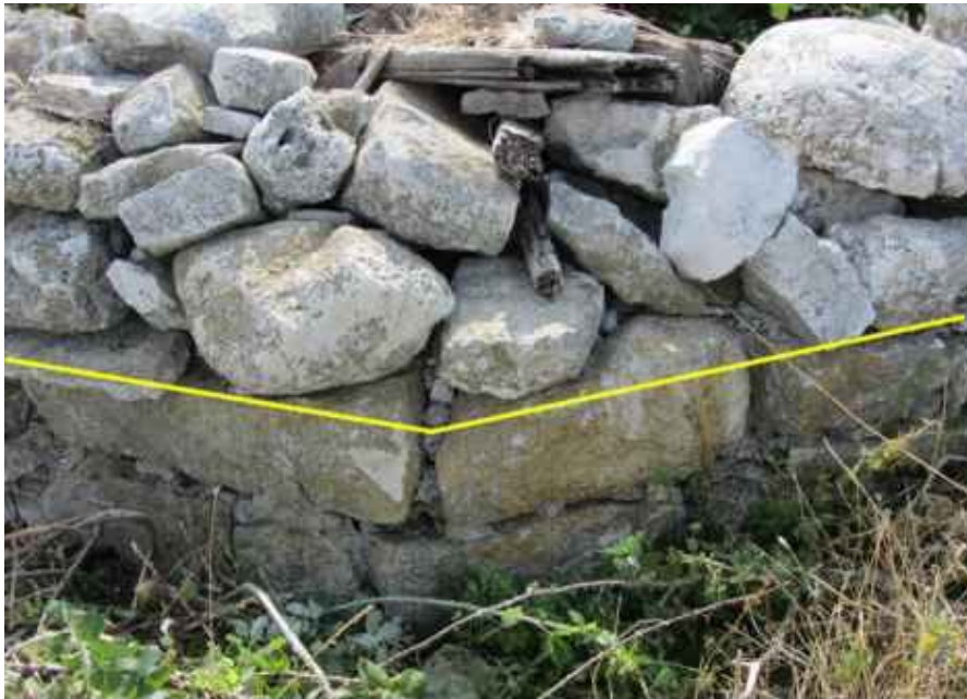
Slika 31. Bodulaš, trag poligonalne građevine (možda apsida) ispod recentno sazidanog zida (foto D. Bulić)
