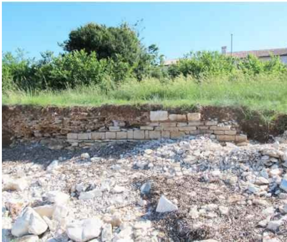
Slika 35. Pošesi, rimski zid (foto: D. Bulić)
